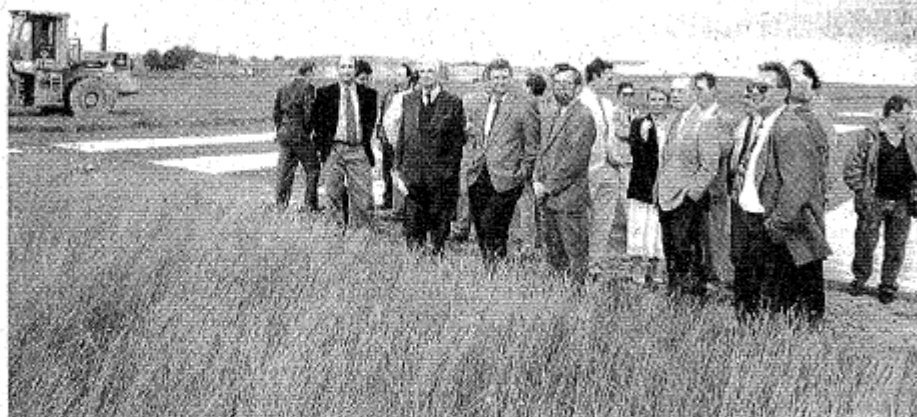
Symboliquement, les travaux d'allongement de la piste de l'aérodrome ont débuté vendredi. Avant d'entrer, dans quelques jours, dans le vif du sujet.
